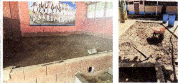
Módulo 2: entornado de concreto
