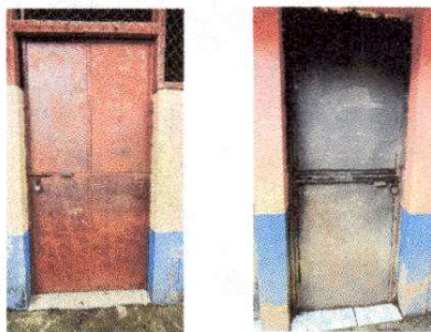
Módulo 2 y módulo 3: Cambio de puerta
